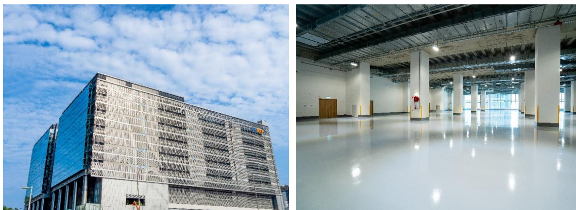
图三及四：位于将军澳创新园的 AMC 是先进制造业的顶尖高端生产基地，当中每层楼的楼底高达 6 米，提供一个可扩展及具专属物流服务的生产空间。
